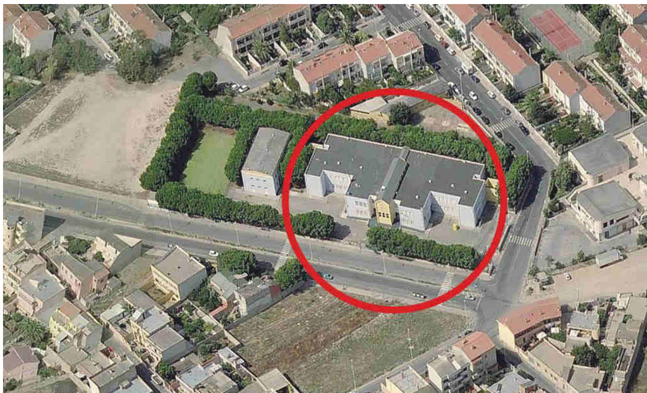
Figura 14 – Struttura di accoglienza Scuola secondaria di primo grado – Istituto Comprensivo Monserrato 1-2 La Marmora. Plesso Via Argentina
