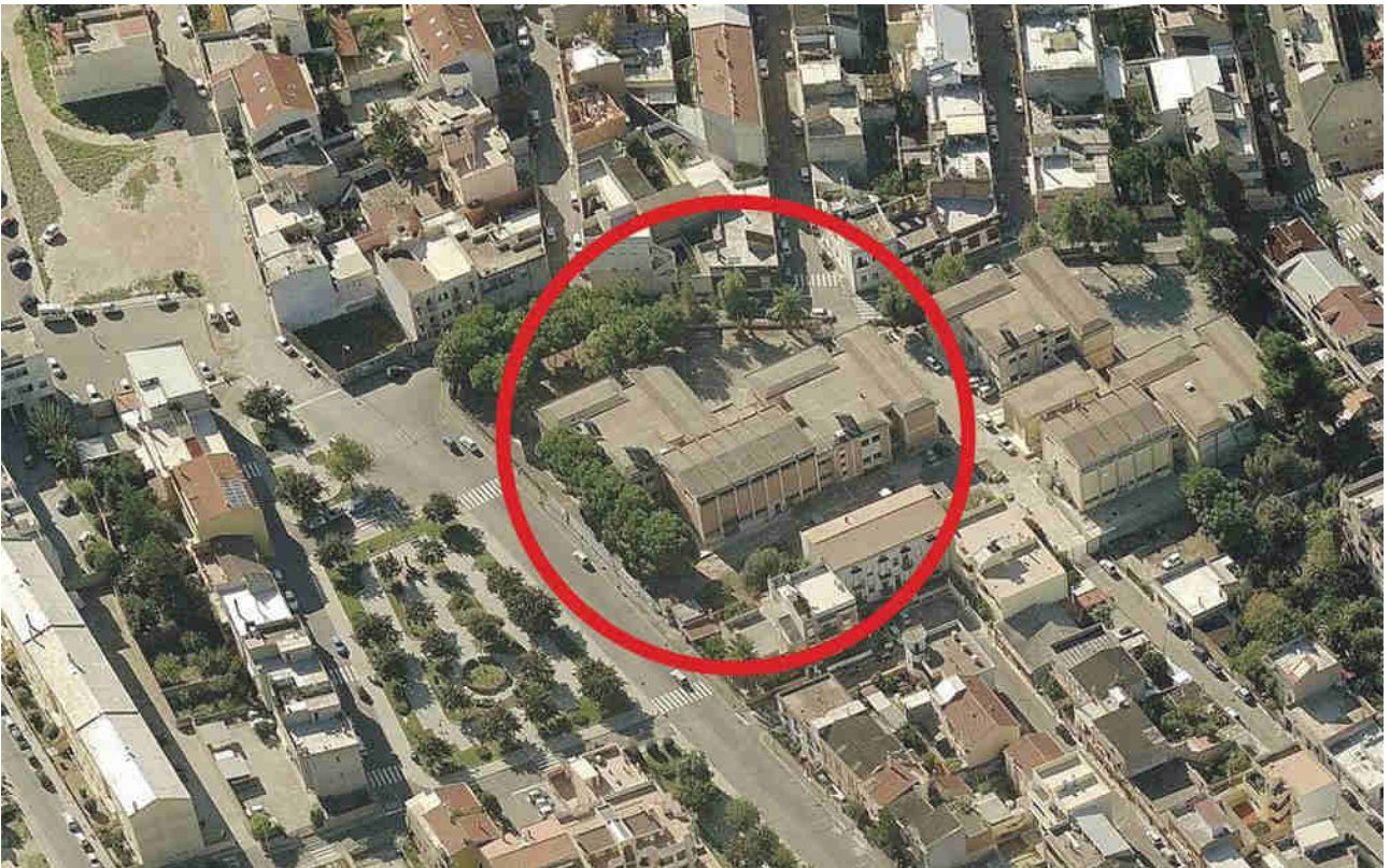
Figura 18 – Struttura di accoglienza Scuola secondaria di primo grado –Istituto Comprensivo Monserrato 1-2 La Marmora. Plesso Via Monte Linas (G. Pascoli) - Vista 2
