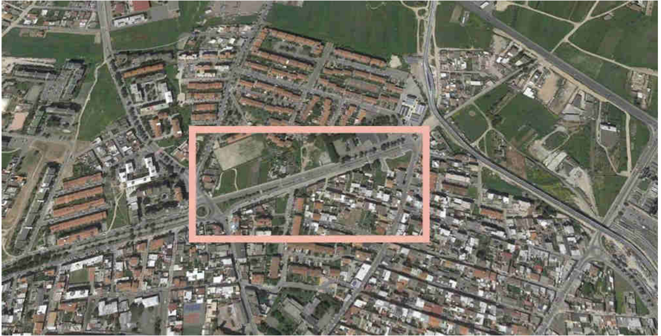
Figura 29 – Parcheggi pubblici in Via dell'Argine - Vista 1
