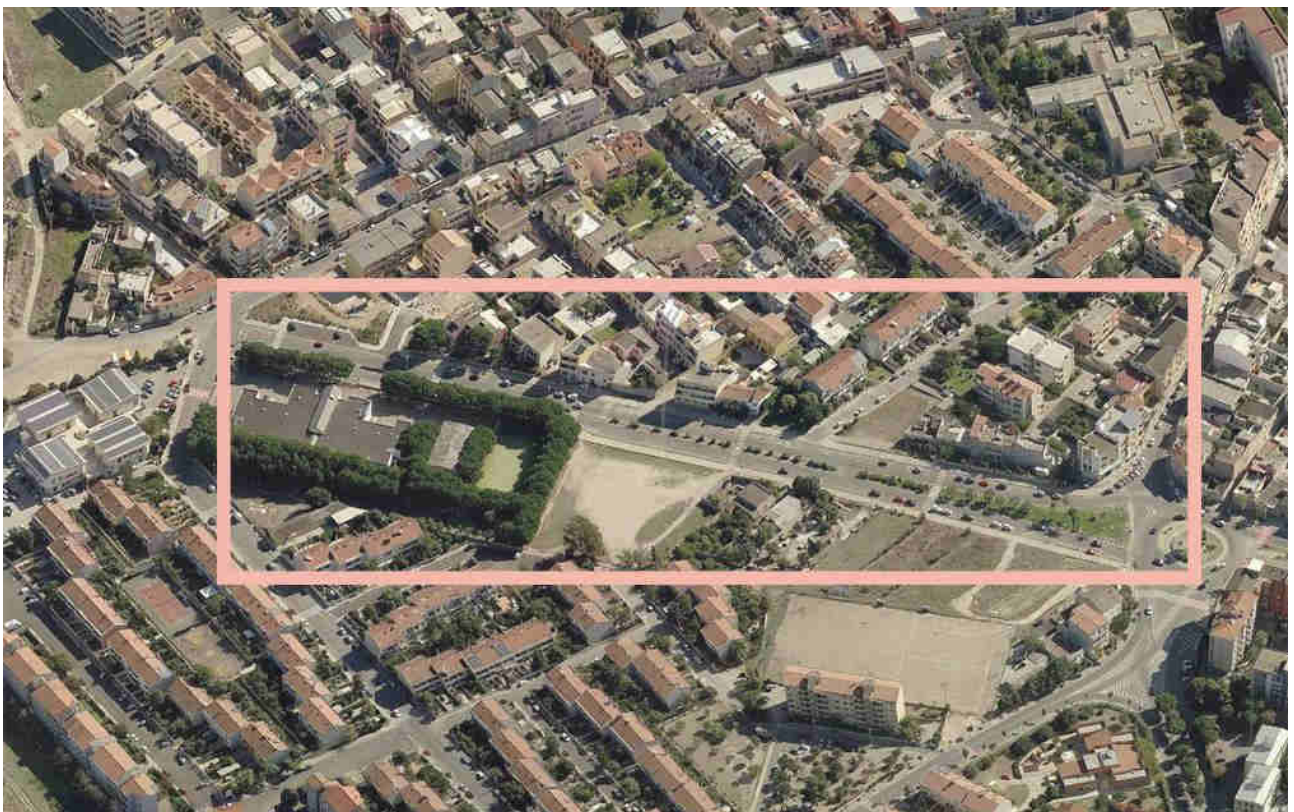
Figura 30 – Parcheggi pubblici in Via dell'Argine - Vista 2
